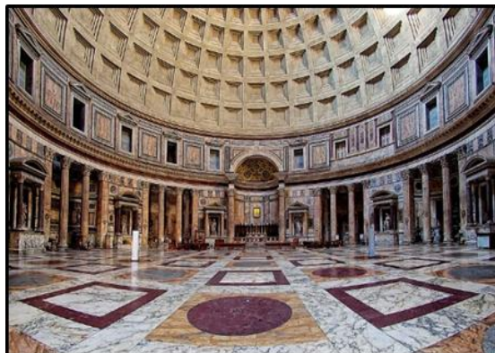
Detail van die interieur van die Romeinse Pantheon . Die koepelplafon bestaan uit gekassetteerde ('coffered') betonpatrone.
